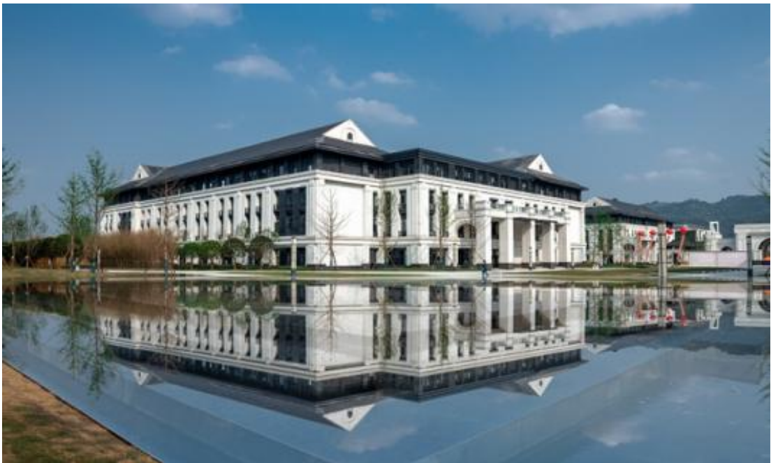
图 2 美丽的宜宾学院临港校区科研大楼（杏林五栋）
