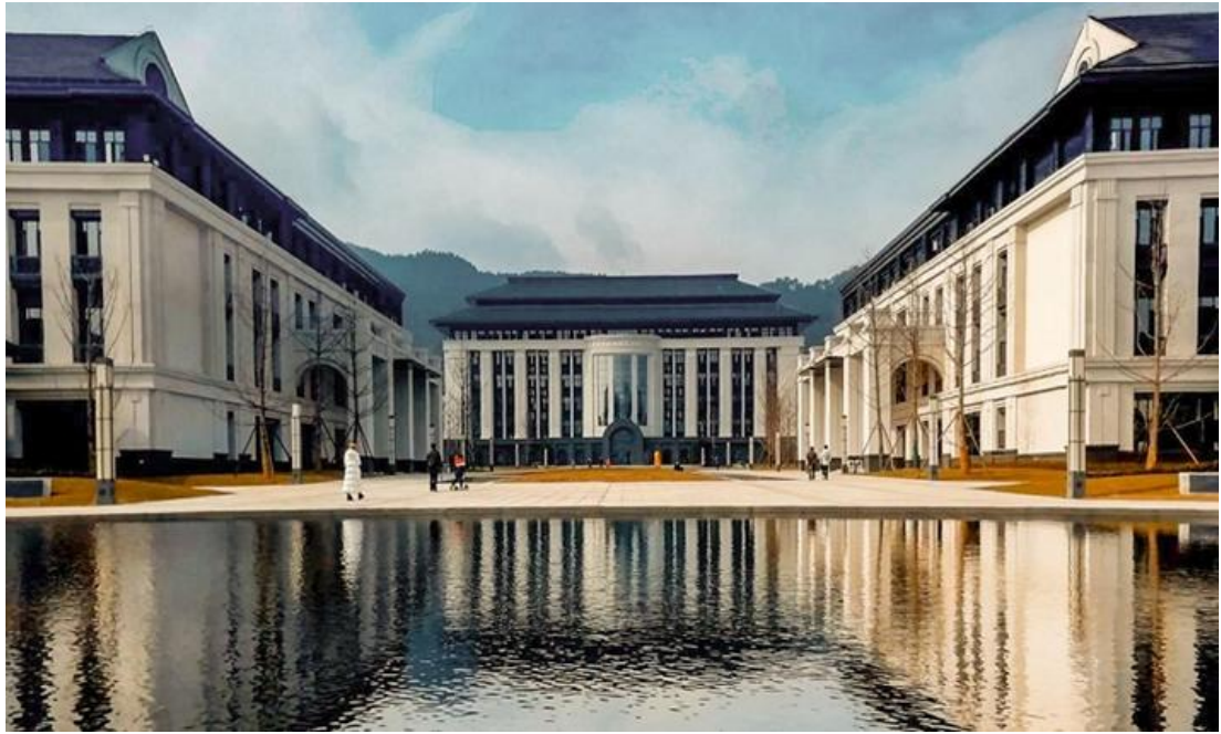
图3 宜宾学院临港校区教学大楼（杏林八栋）
